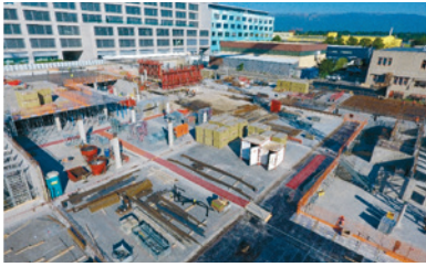
Projekt Spark, Beginn der Rohbauarbeiten, Anfang 2021
